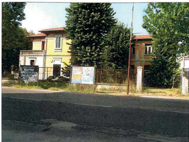
Vista da Via Alghieri dell'edificio oggetto di ristrutturazione e miglioramento sismico
