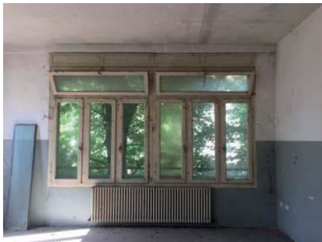
Locali interni piano primo
