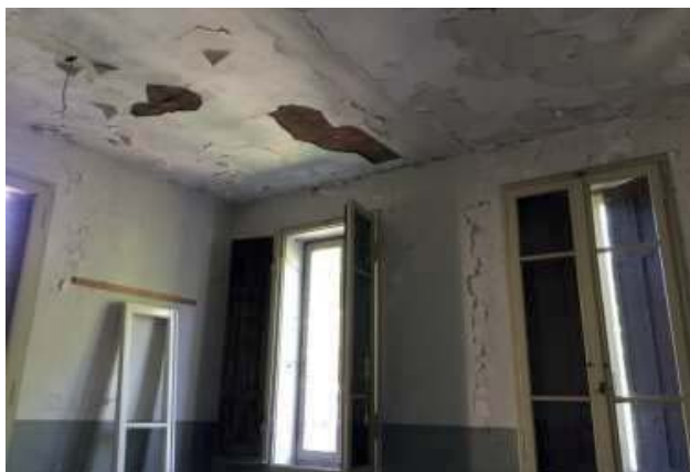
Locali interni piano primo
