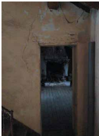
Interni: lesioni in corrispondenza delle aperture
