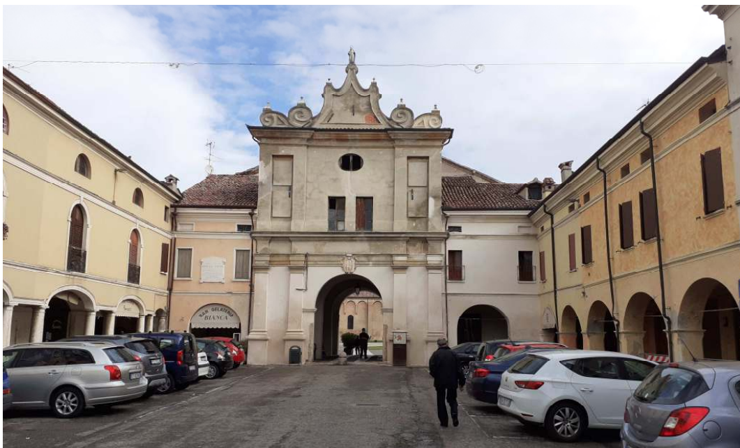
Vista edificio dal lato sud da piazza Matteotti
