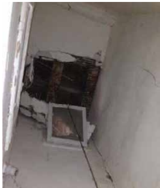
Interni: lesioni in corrispondenza delle aperture
