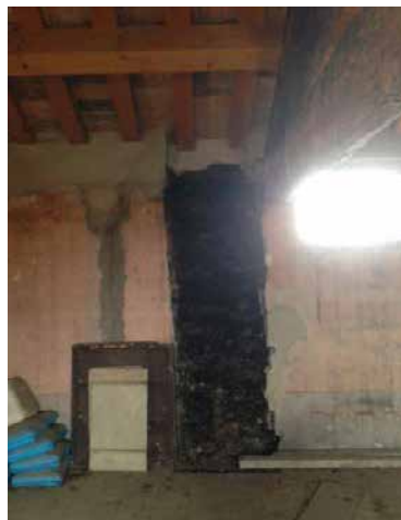
Interni: lesioni in corrispondenza delle aperture
