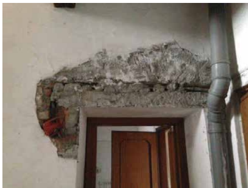
Interni: distacchi di porzioni di intonaco
