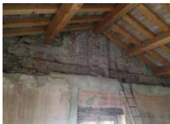
Interni: lesioni in corrispondenza delle aperture
