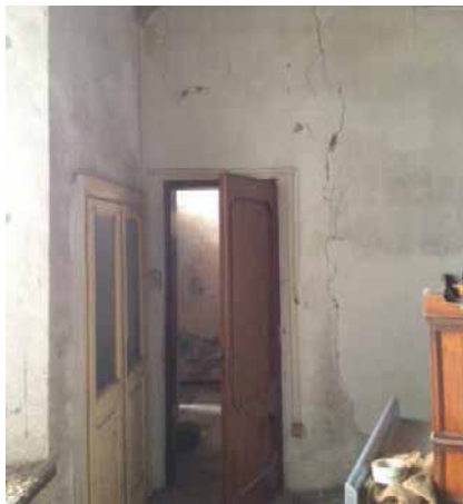
Interni: lesioni in corrispondenza delle aperture
